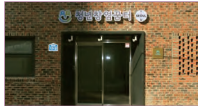
공사 후 - 외관
